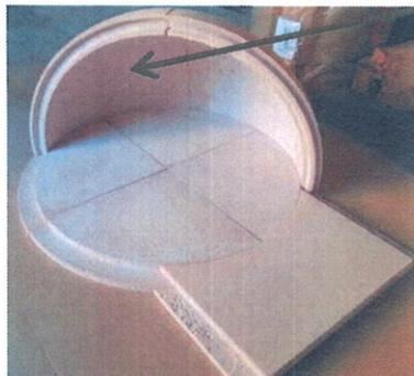
7. Poté položíme zbývající 2 díly kopule (tvarovku kopule a tvarovku vstupu) tak, aby v zámcích dobře dosedly k sobě. K finálnímu dotěsnění použijeme pouze vlastní ruce, nebo jemným poklepem dotěsníme pomocí gumové palice.
